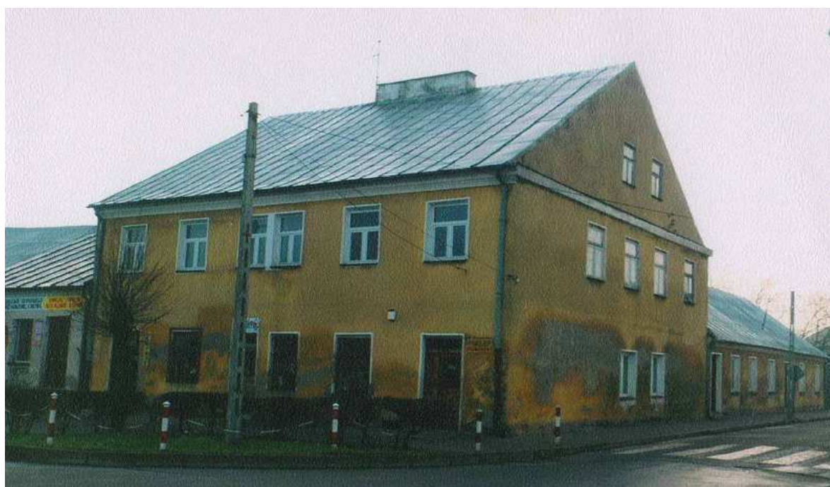
Rys. 9 Dom nr I, ul. Tysiąclecia - mur., k . XVII w . – nr rej.201
