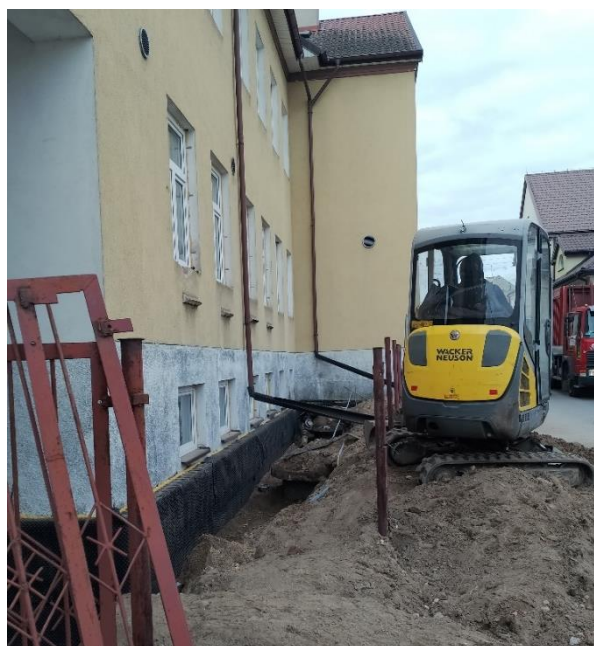
Fot. Wykonanie drenażu i ocieplenie ścian fundamentowych Szkoły przy ul. Plac 1000 lecia 14.
