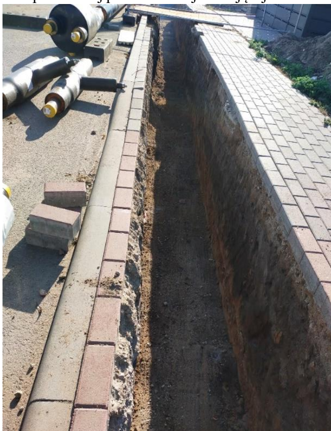
Fot. Wykop pod elementy sieci ciepłowniczej w ul. Łąkowej
