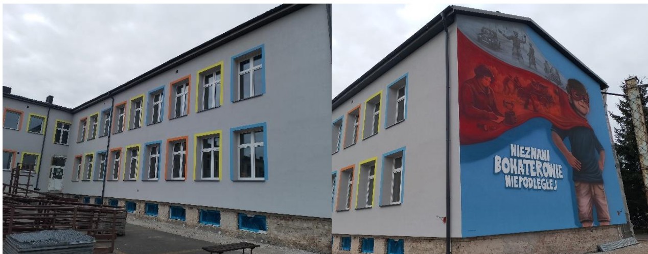
Fot. Elewacja obiektów szkolnych przy ul. Kilińskiego 42 w m. Szczuczyn
