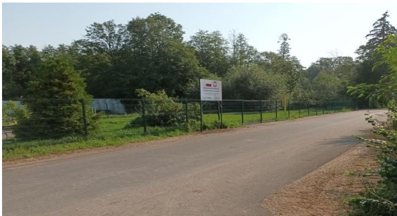
Fot. Fragment przebudowanej drogi gminnej w sąsiedztwie świetlicy wiejskiej we wsi Bzury
