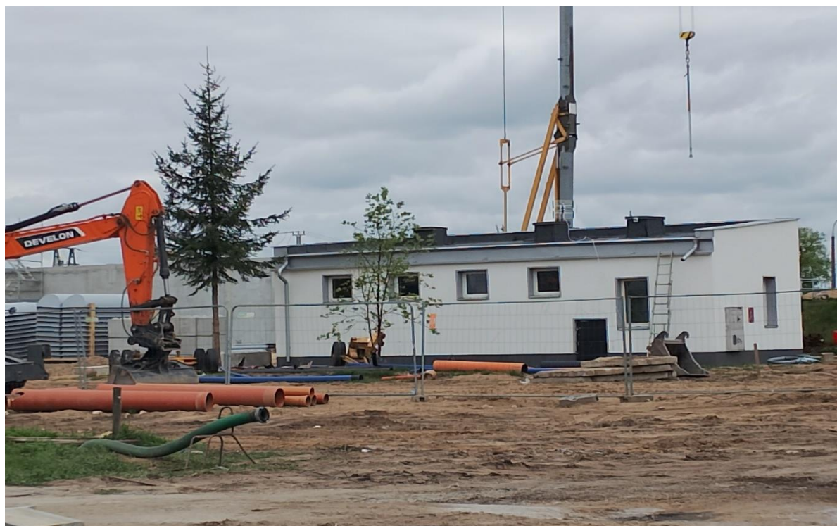
Fot. Roboty budowlane przy obiekcie nr 10 miejskiej oczyszczalni ścieków.
