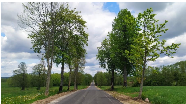
Fot. 1. Droga gminna Czarnówek – Niedźwiadna (w budowie)
