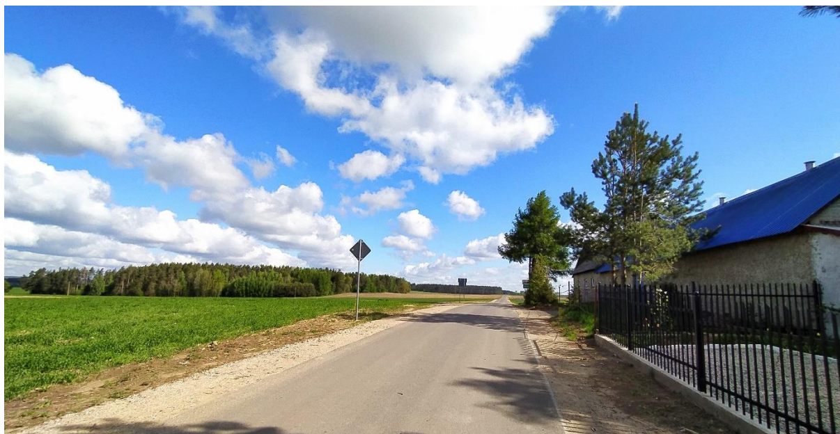
Fot. 5 Przebudowany odcinek drogi w m. Dołęgi.
