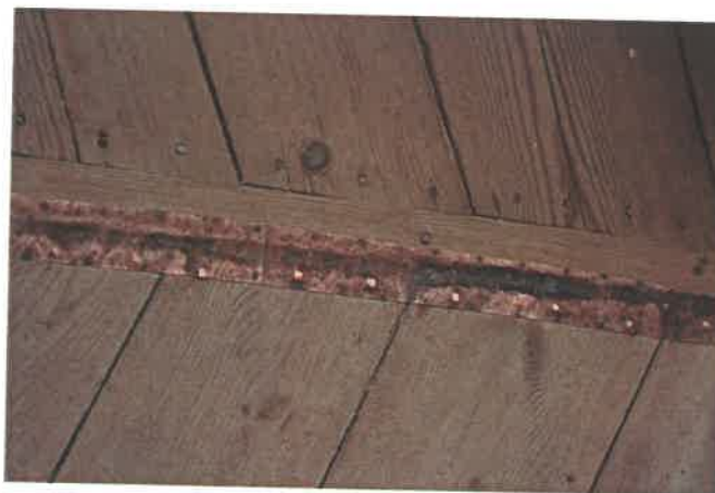
Fot. 1 Łączenie przykryte blachą
