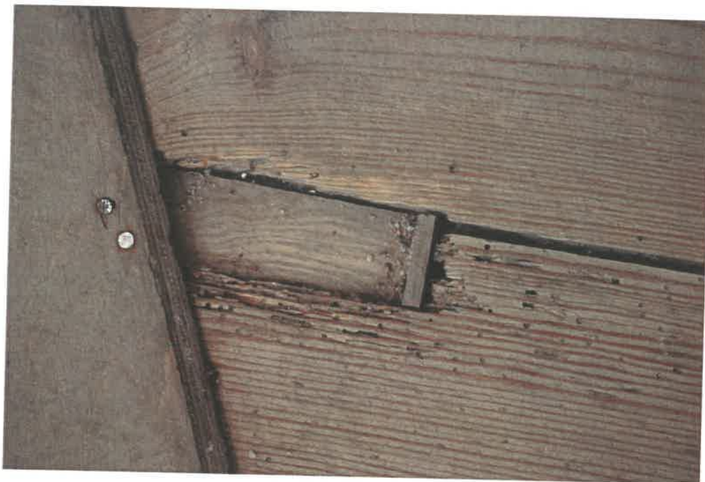
Fot. 2 Wypełnienie ubytku sklejką
