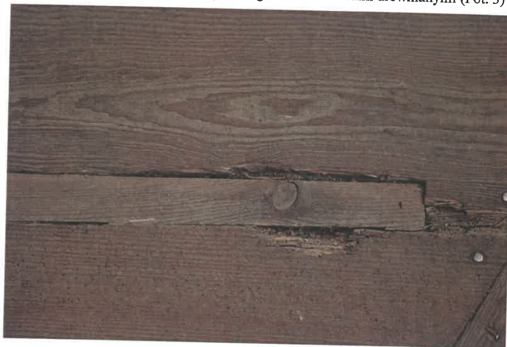
Fot. 3 Uzupełnienie listwą drewnianą
