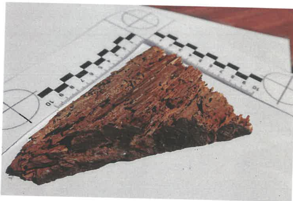
Fot. 18 Destrucja drewna - warstwa dolna
