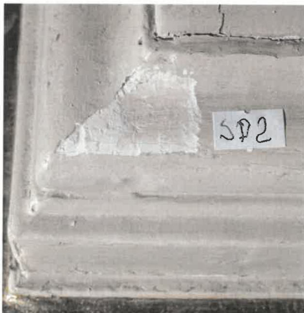
ODKRYWKA 2 układ od góry: kremowa warstwa malarska biała warstwa malarska grunt polerowany(?) drewno
