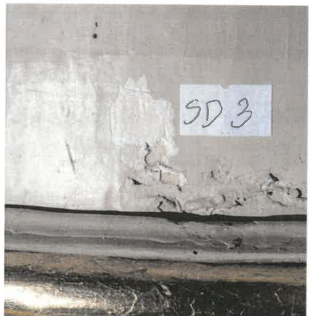
ODKRYWKA 3 układ od góry: kremowa warstwa malarska biała warstwa malarska grunt polerowany(?) drewno
