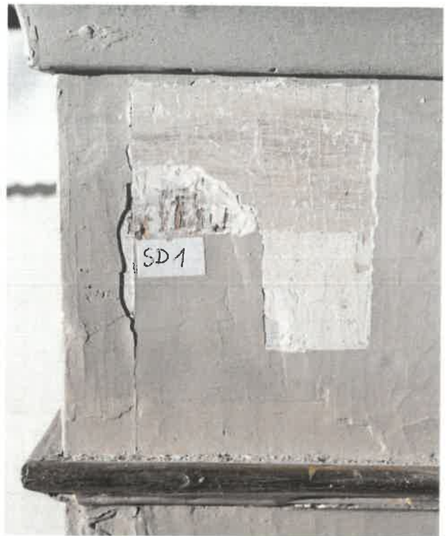
ODKRYWKA 1 układ od góry: kremowa warstwa malarska biała warstwa malarska grunt polerowany(?) drewno
